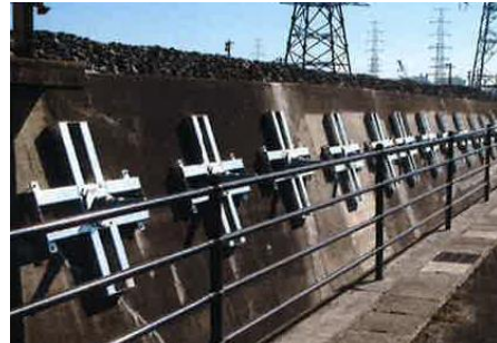
土留擁壁防護工事
