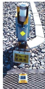
ヒヤリ・ハット改善策 「歩行路にソーラーライト設置」
