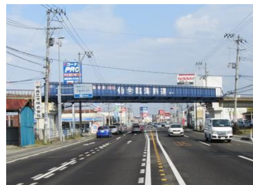
橋りょう塗装工事
