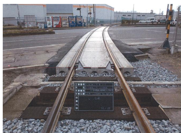
踏切接続軌道ブロック取替（工事後）
