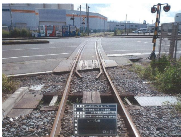
踏切接続軌道ブロック取替（工事前）
