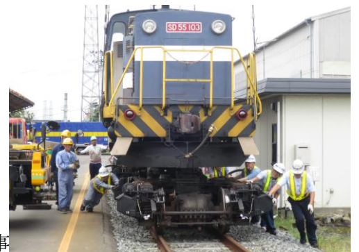
SD55-103号 車体分離作業
