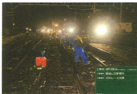
〈レール交換作業〉
